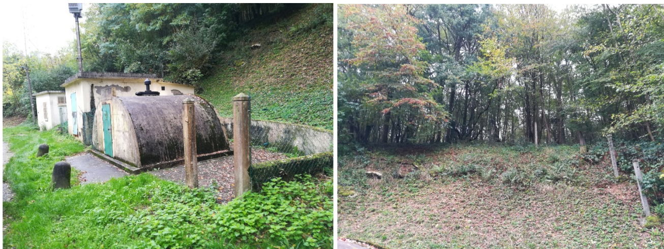
Figure 4 : clôture du captage.
